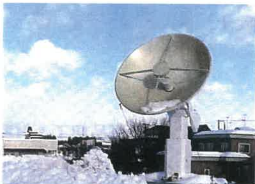
人工衛星追尾パラボラアンテナ (褶動性・耐候性機能)
