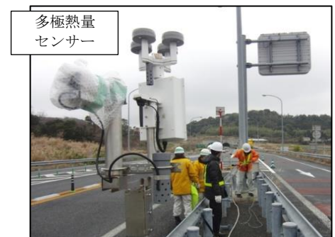
図7 多極熱量センサー設置状況
